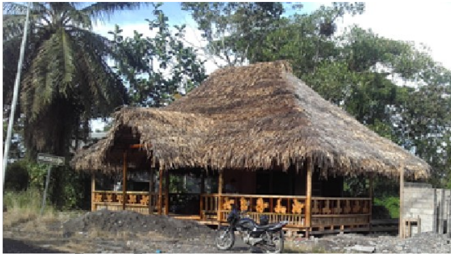
Foto 4. Restaurante de la Asociación Challuwa Mikuna construido con apoyo del PSF
